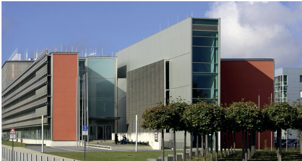
Abb.: Das Leibniz-Rechenzentrum (August 2011, mit Erweiterung). Bild: LRZ
