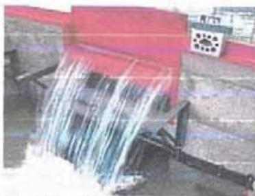
*Abb. 8 Verschlussstafelstellung bei Rechenreinigung*
