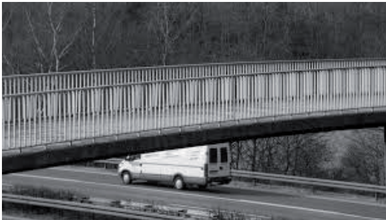
Abbildung 1: Moiré-Muster an einem Brückengeländer [2]
