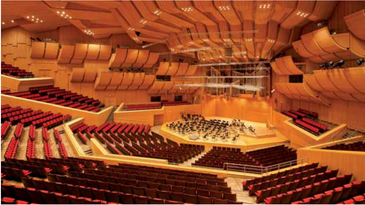
Abbildung 15: Diffusoren an den Wänden 39
