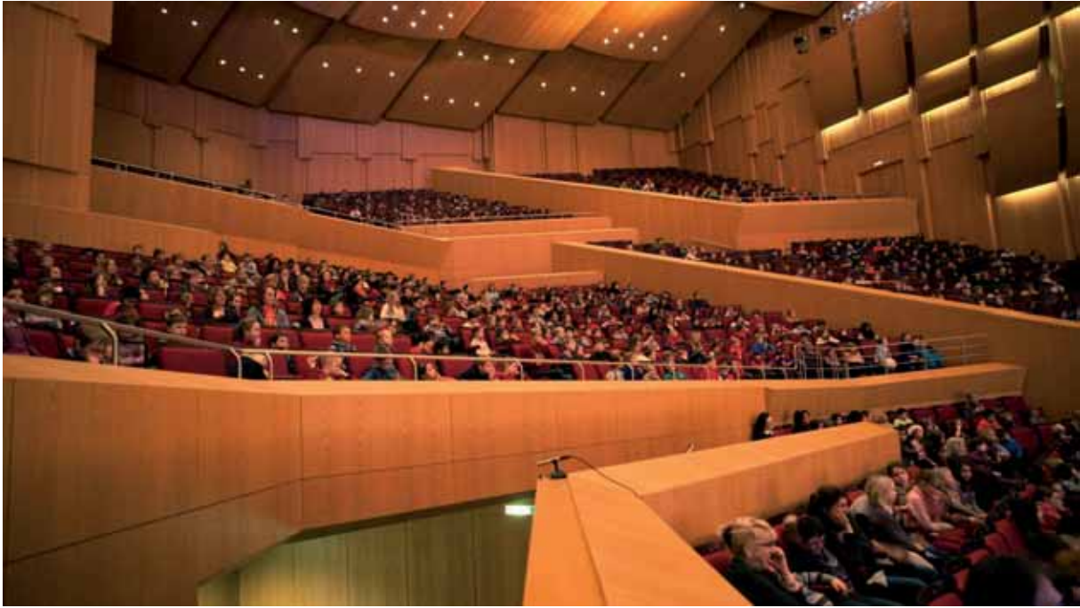
Abbildung 17: Abschrägung hinten an Decke und über Abgängen 41
