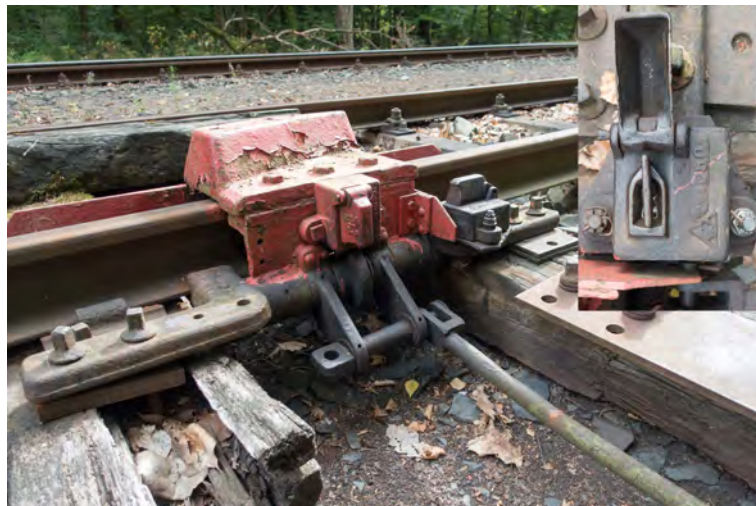
Abbildung 3: Gleissperre in Sternhaus-Ramberg mit zwei Handschlössern. Der Zugführerschlüssel passt in das rote Handschloss. Im umgelegten Zustand wird ein Schlüssel freigegeben, der in das Handschloss der Weiche passt.
