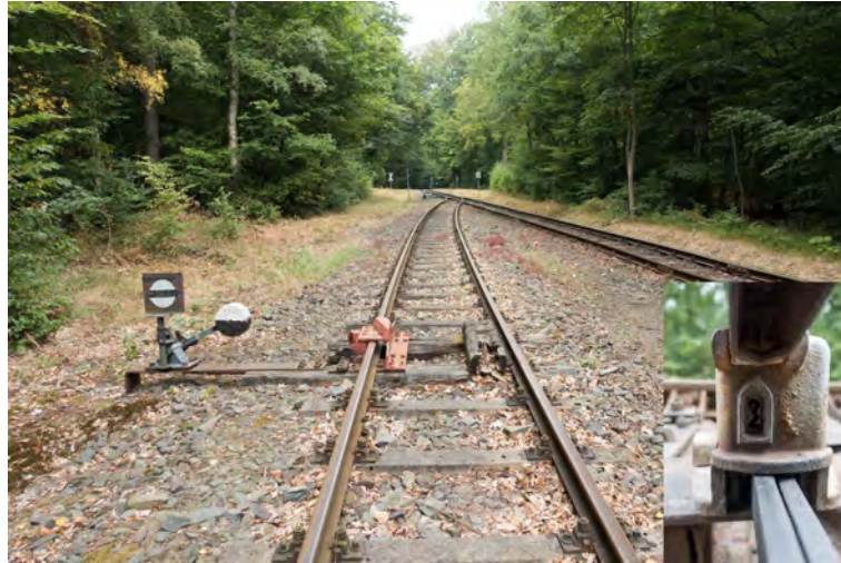
Abbildung 2: Überblick über die Gleisanlagen in Sternhaus-Ramberg. Das rechte Gleis ist das Hauptgleis. Die Weiche im Hintergrund ist in Grundstellung verschlossen.
