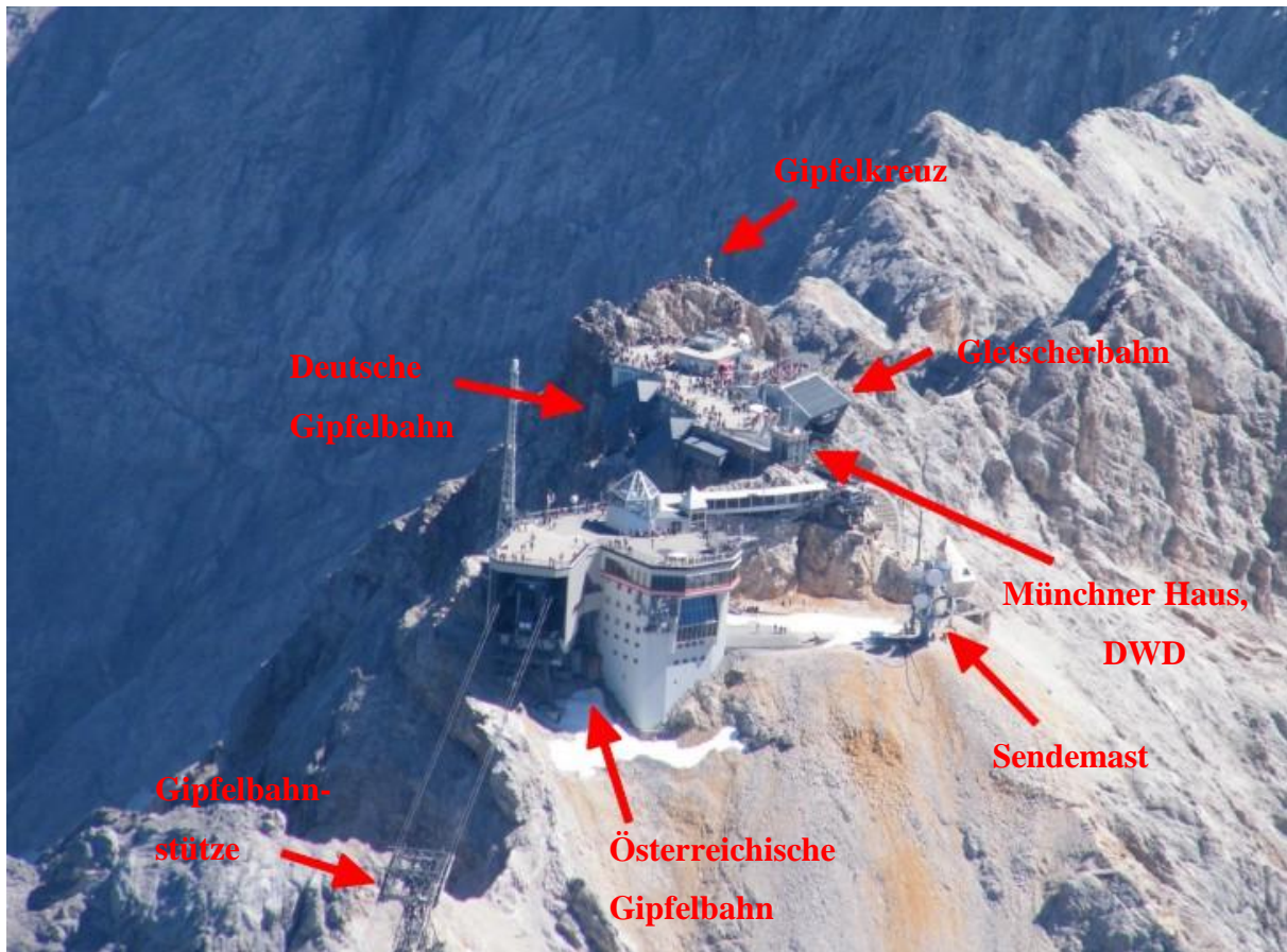
Abb. 14: Bauwerke am Zugspitzgrat
