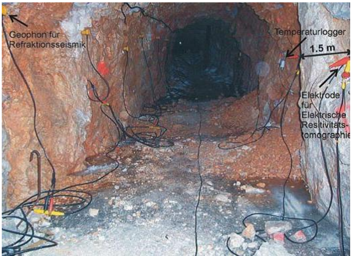
Abb. 8: Messstrecken im Kammstollen
