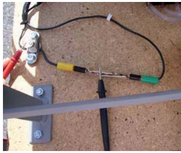
Abb. 22: Vorgang der Spannungsmessung
