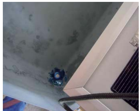
Abb. 38: Wasserabfluss mit Dichtmasse fixiert
