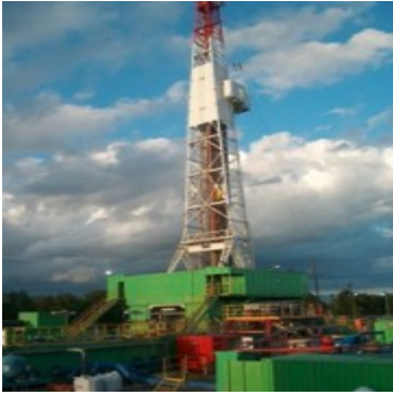
Abb.9: Nach langer Verzögerung wurde der Bohrturm für die zweite Bohrung aufgestellt (Quelle: Knappek)
