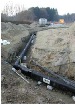
Abb.10: Verlegung der Rohre für das Fernwärmenetz (Quelle: Knappek)
